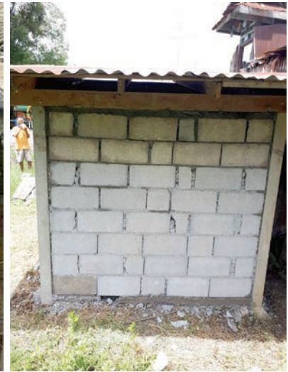
หลังซ่อม
