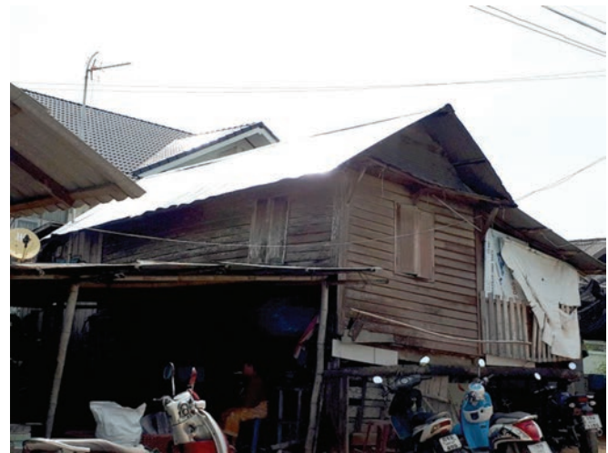
หลังซ่อม
