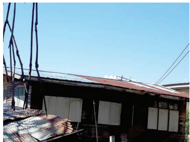
หลังซ่อม
